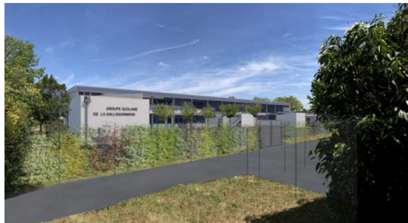
La réhabilitation complète de l'école La Gallissonnière prolonge celle du Petit Marseille. À la rentrée 2020, le groupe scolaire sera informatisé et entièrement accessible.
