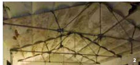
3. Charpente métallique du bâtiment principal (©Cabinet AUP)
