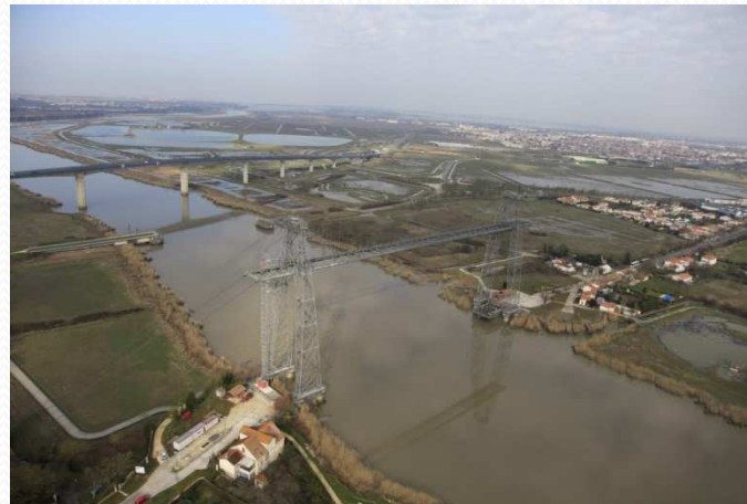
Rochefort – Pont Transbordeur
