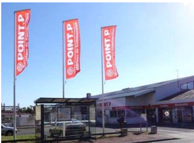
Hauteur non conforme
