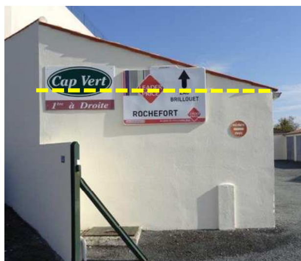
Au dessus du niveau de l'égout du toit et absence d'alignement horizontal
