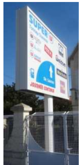
Support épais, finition imparfaite du caisson
