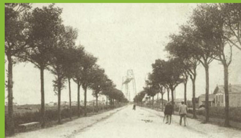
La route du Transbordeur : les constructions sont rares. Photographie, fonds numérique Donnou, Archives municipales de Rochefort
