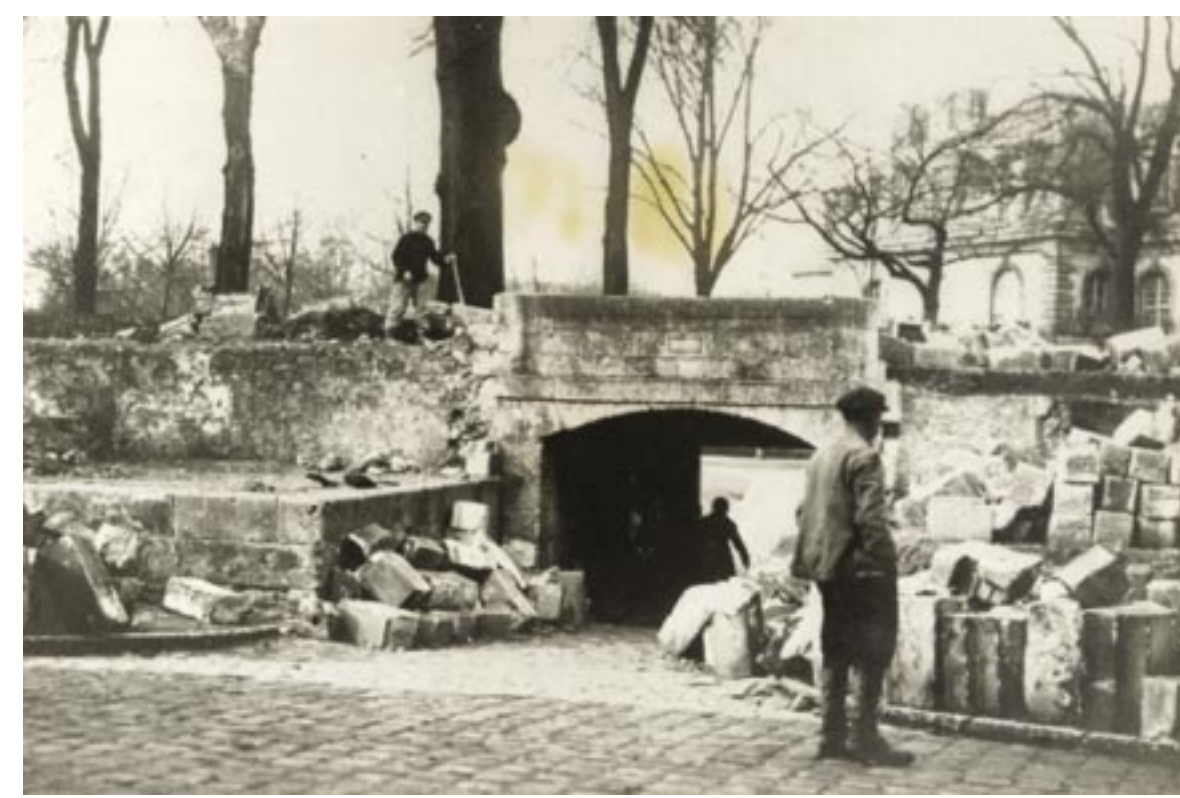
La poterne Saint-Charles en cours de démolition. Photographie, fonds numérique R. Allary, Archives municipales de Rochefort
