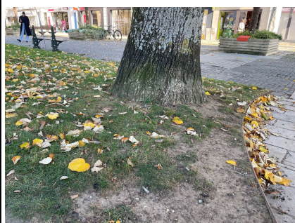
Aucun signe d'affaissement du sol
